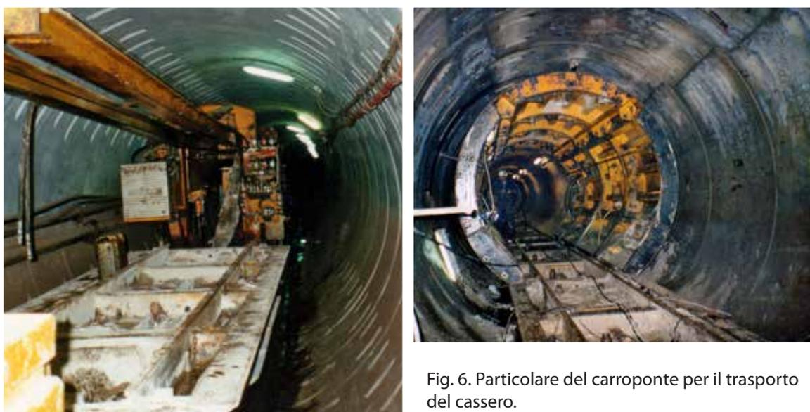
Fig. 6. Particolare del carroponete per il trasporto del cassero.
