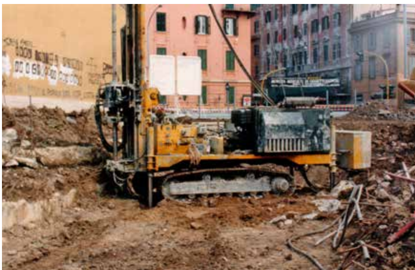
Fig. 7. Fasi della realizzazione del tappo di fondo.
