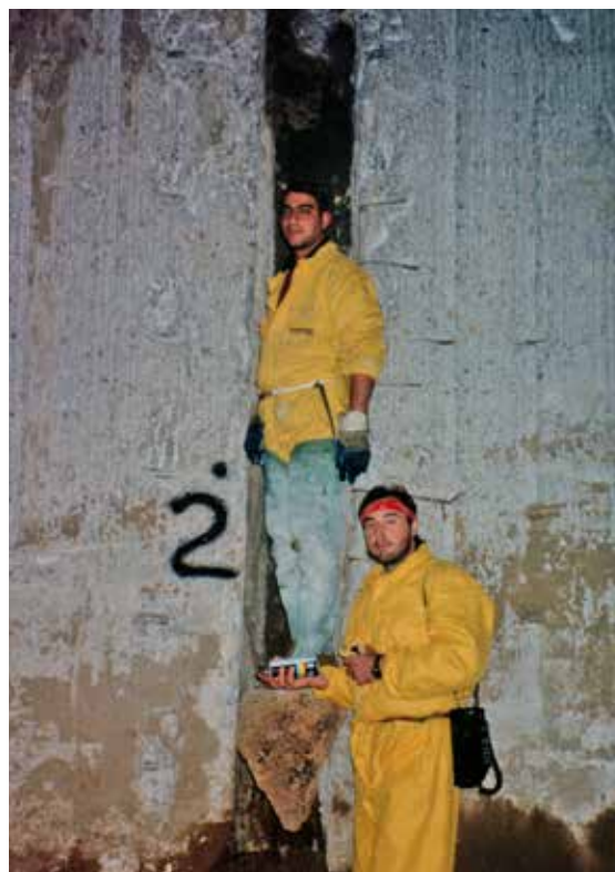
Fig. 6. Vista di una divisione tra i pannelli componenti le paratie.
