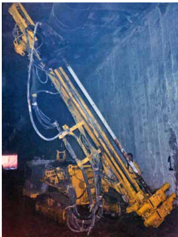
Fig. 5. Intervento sulle paratie.
