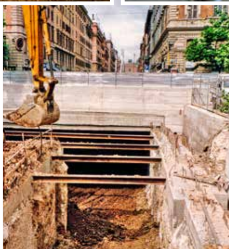
Fig. 10 - 12. Immagini dello scavo della galleria.
