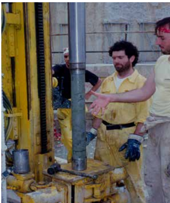
Fig. 8. Fase di carotaggio.
