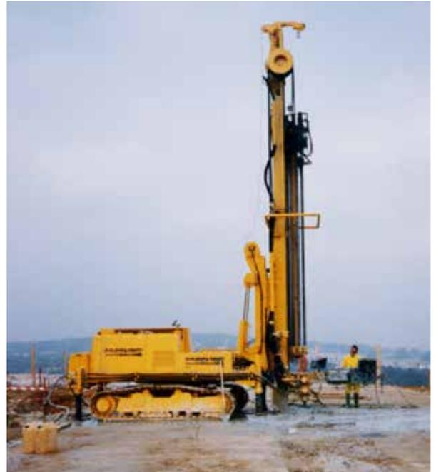
Fig. 5 - 6. Sondaggio delle colonne Jet Grouting proveniente dal campo prove e perforatrice P 1500 ESCR impegnata nel campo prove.
