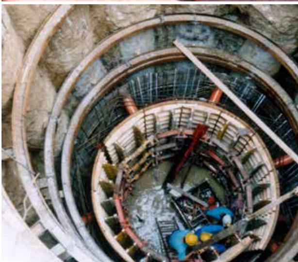
Fig. 6. Fase di montaggio del cassero.
