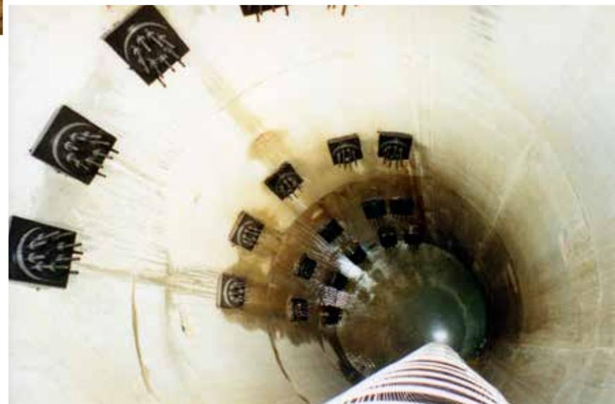
Fig. 10. Interno del tunnel con vista delle teste dei tiranti.
