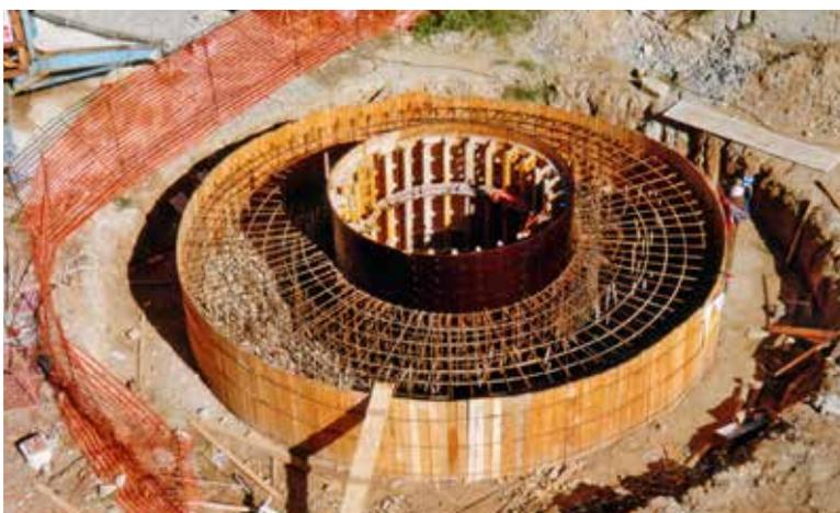
Fig. 8. Armatura del cordolo del pozzo.
