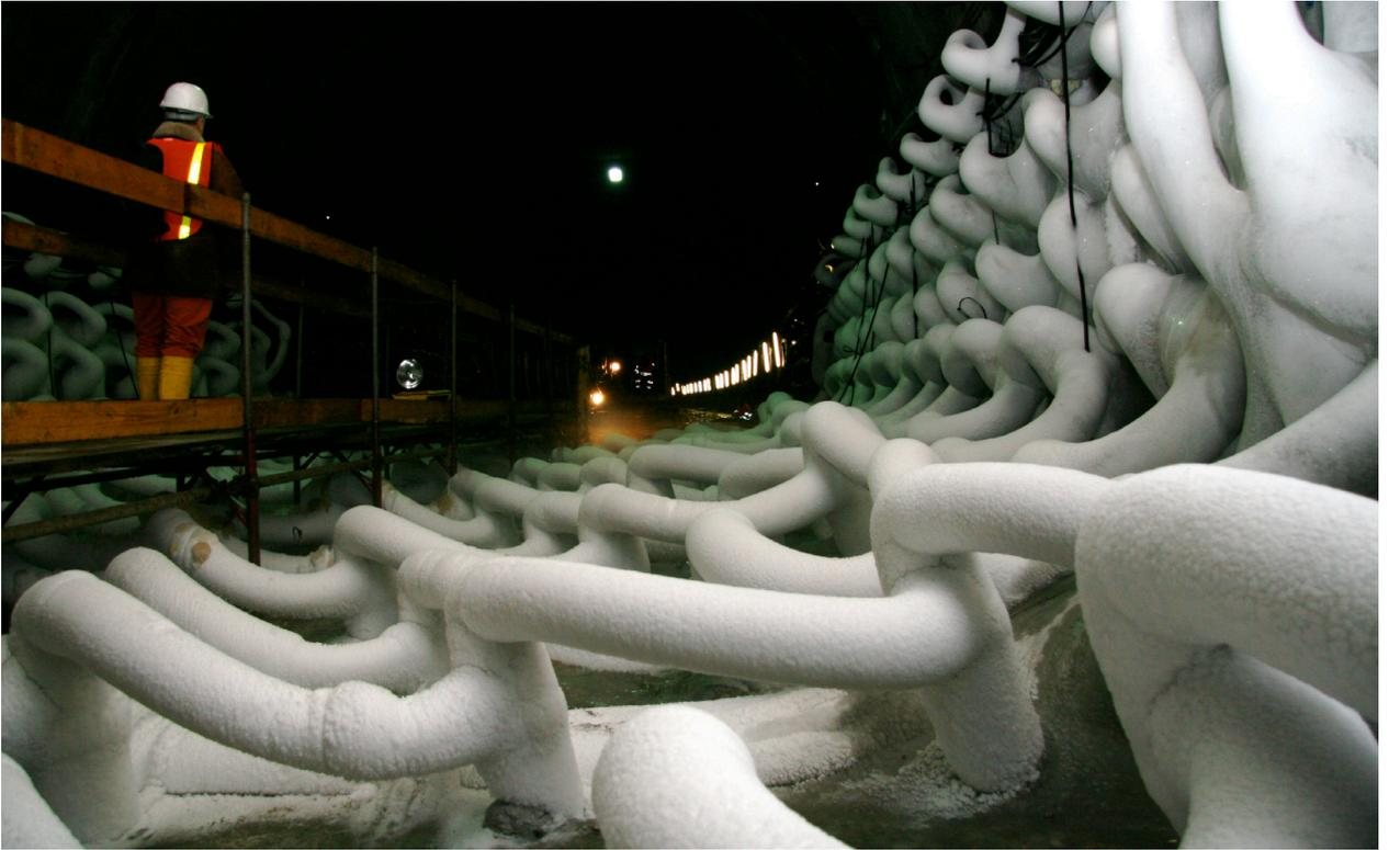
Fig. 16. Particolare delle testine con i manicotti di collegamento; campo in congelamento.
