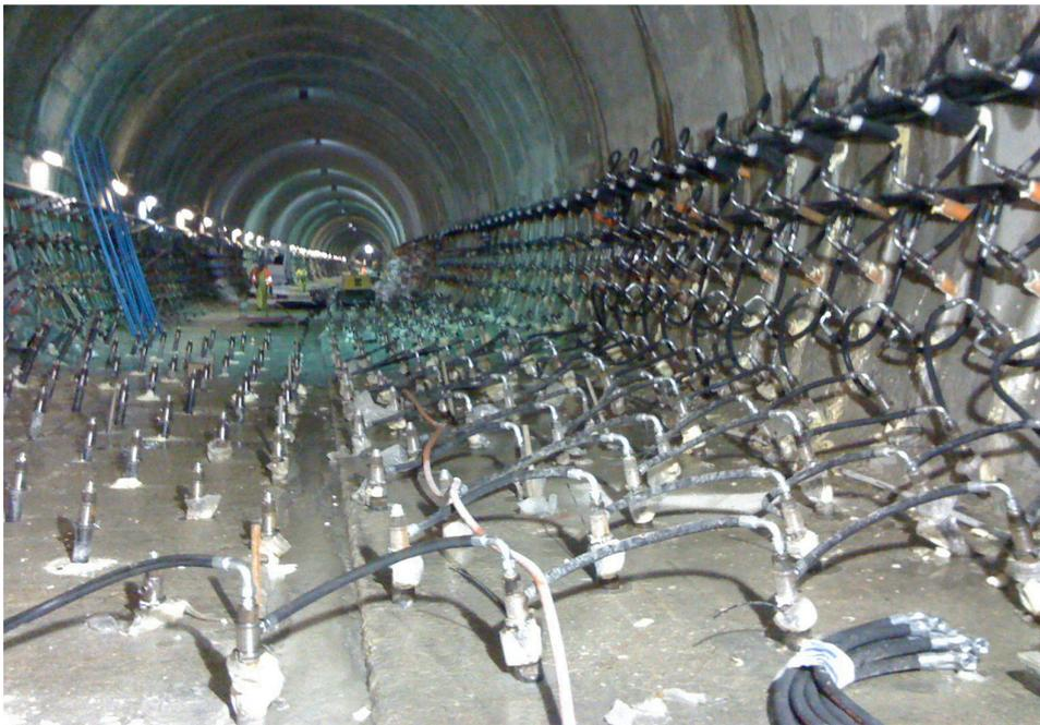
Fig. 12. Panoramica dei campi attrezzati ma non ancora in congelamento.
