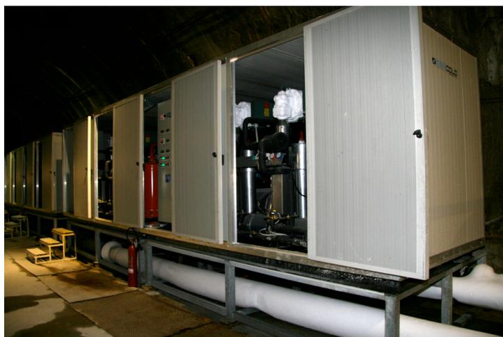
impermeabile e staticamente efficiente una volta raggiunte le temperature di esercizio ottimali, sfruttando proprio la debolezza intrinseca degli ammassi di terreno interessati, vale a dire la presenza dell'acqua.
