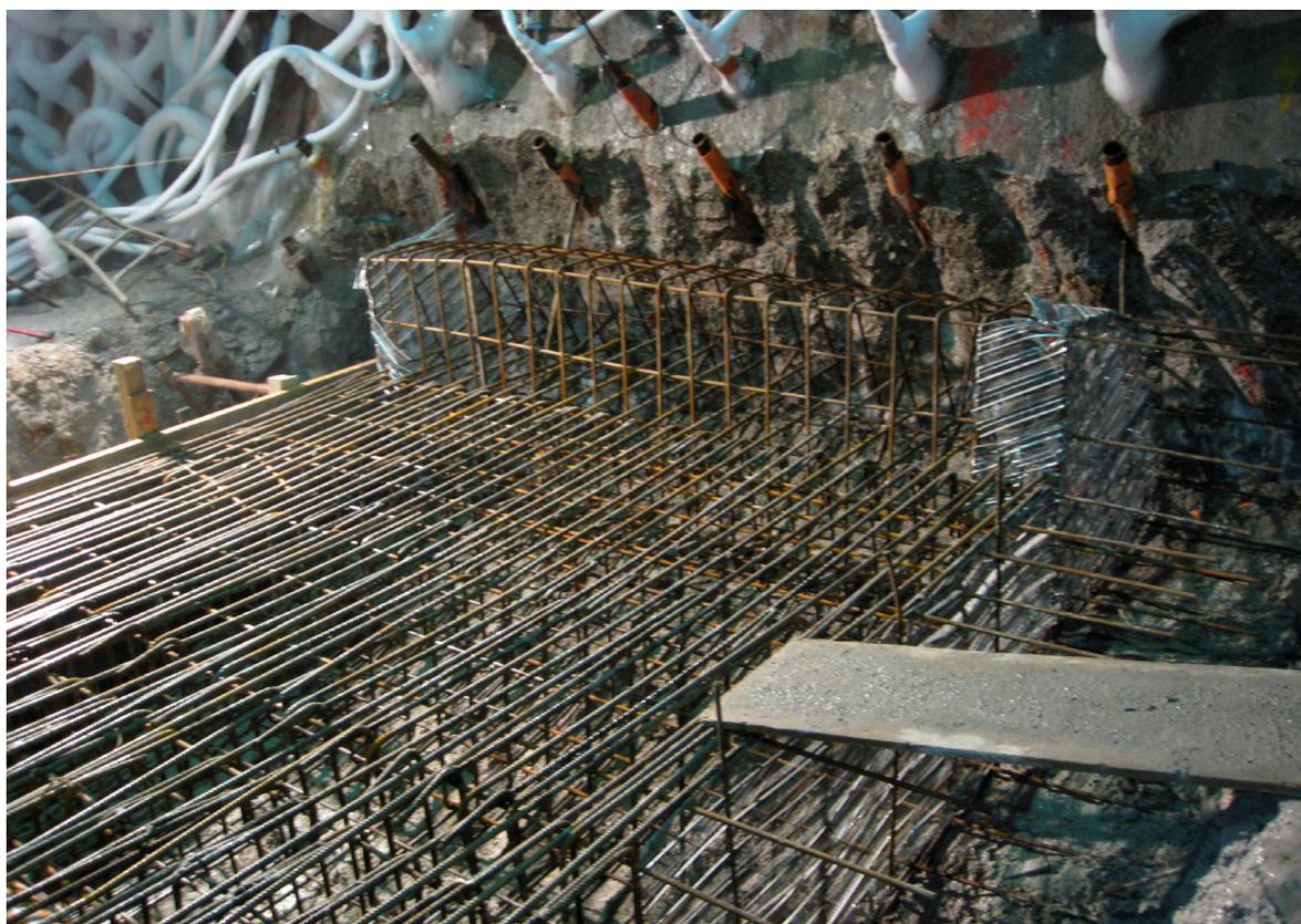
Fig. 18. Concio in ricostruzione; montaggio gabbia di armatura per il getto definitivo.
