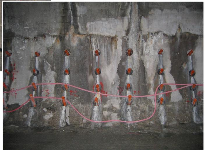
Fig. 4. Schema tipico di raggiera di sonde congelatrici (e termometriche).
