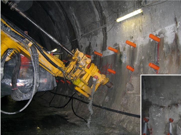
Fig. 3. Perforazioni eseguite nei piedritti l'installazione delle sonde congelatrici (e termometriche).
