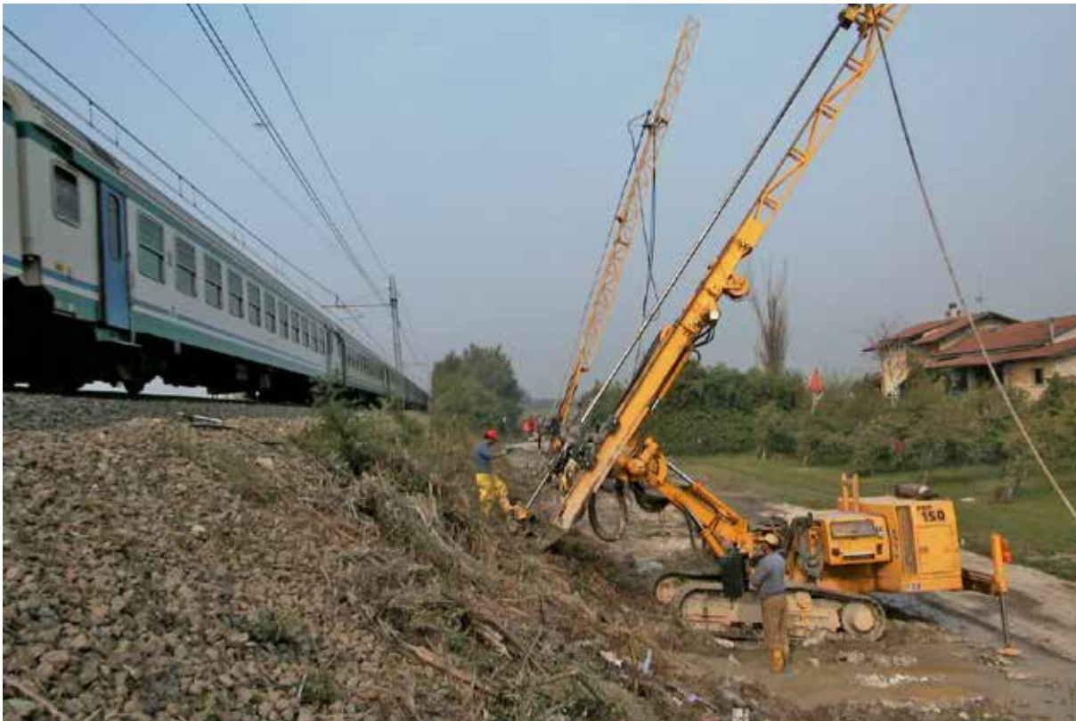
Fig. 1. Sonda PRP 150 durante l'esecuzione dei lavori.
