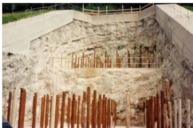
Fig. 12. Vista delle armature delle colonne.
