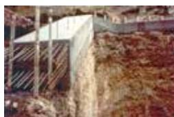
Fig. 5. Vista di una trave della cuffia di protezione.
