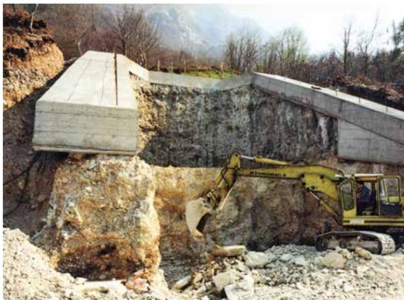
Fig. 6. Scavo per imposta della fondazione.
