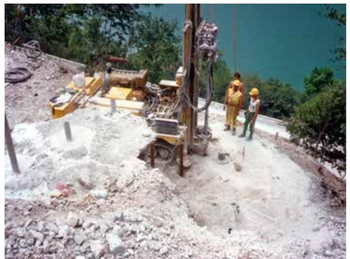
Fig. 4. Sonda P 800 durante il Jet Grouting per la realizzazione delle cuffie di protezione.
